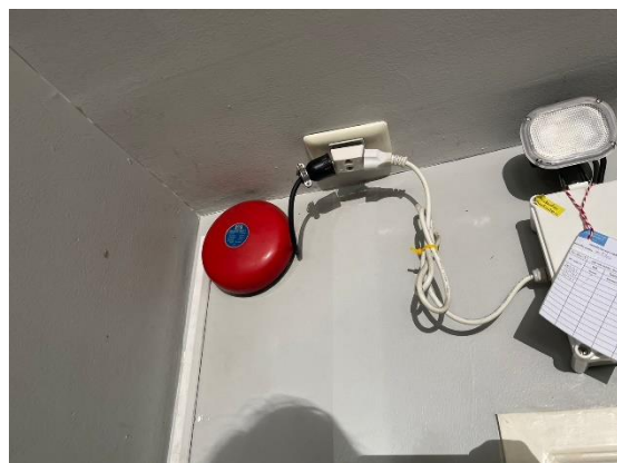
รูปที่ 20 กริ่งสัญญาณเตือนอัคคีภัย
